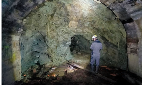
Voûte maçonnée pour soutenir et consolider la cavité
