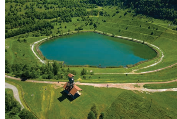
Ci-dessus, La Découverte de Decazeville mise en eau et revégétalisée après l'arrêt de l'exploitation
