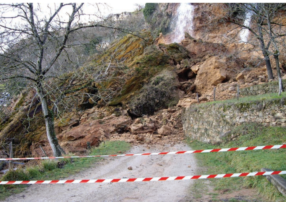
Ci-dessus : Salles-la-Source Ci-contre : Salles-la-Source - 2005
